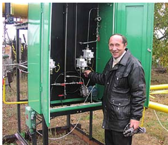
Инженер-метролог Леонид Давидович демонстрирует новый комплекс одоризации газа
